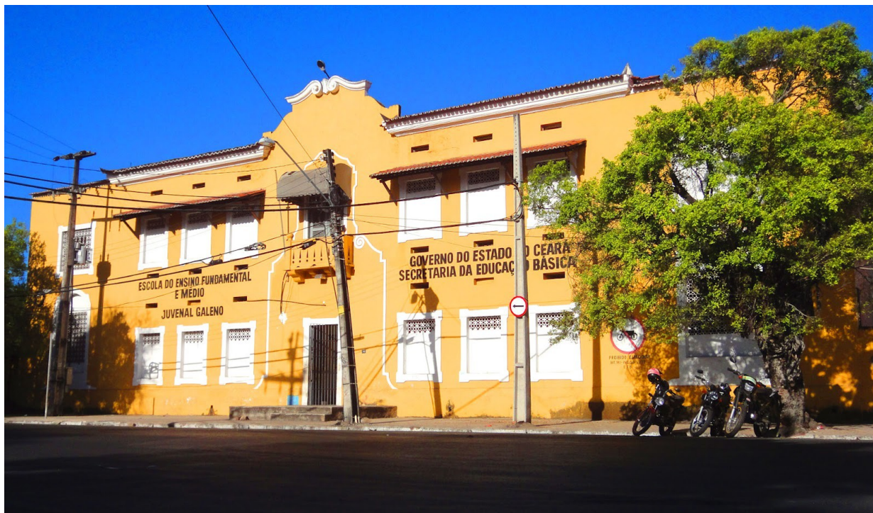
Foto 08. Prédio do Centro de Referência sobre drogas do Estado do Ceará (CRD).
