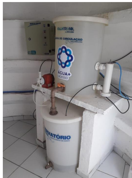
Fábrica de Cloro
