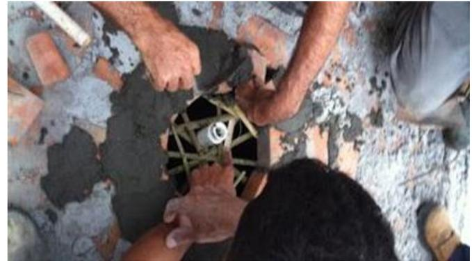
**Biodigestor -Construção do modelo chinês de alvenaria de tijolos (sem tampa na cúpula). Fonte: Taboa Engenharia / Vale Encantado**
