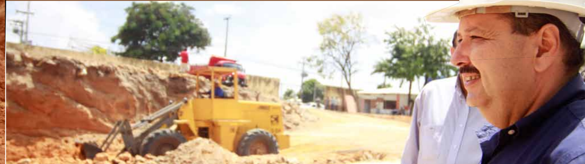
&gt;&gt; Deputado Domingos Filho (PMDB) inspeciona o andamento dos trabalhos no canteiro de obras do Anexo II da Casa.
