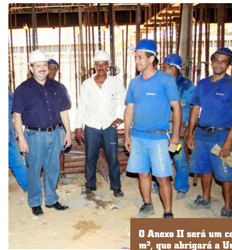
&gt;&gt; Deputado Domingos Filho visita as obras do novo estacionamento no subsolo do prédio da AL.
