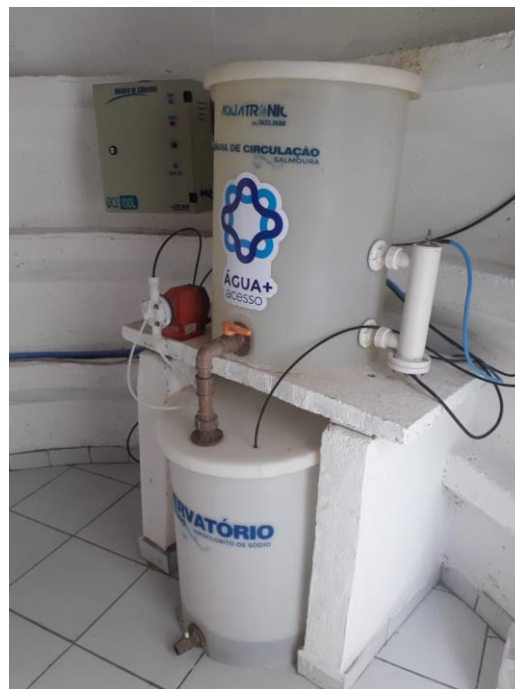
Fábrica de Cloro
