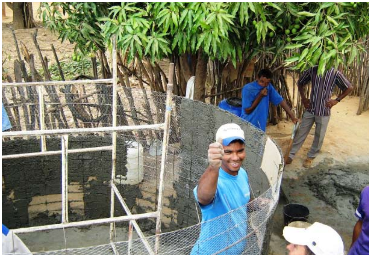
Construção de cisterna
