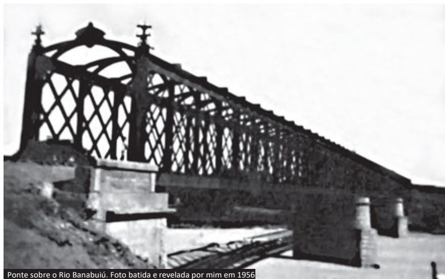
Ponte sobre o Rio Banabuiú. Foto batida e revelada por mim em 1956
