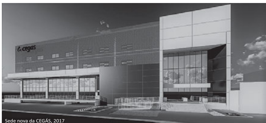
Sede nova da CEGÁS, 2017
