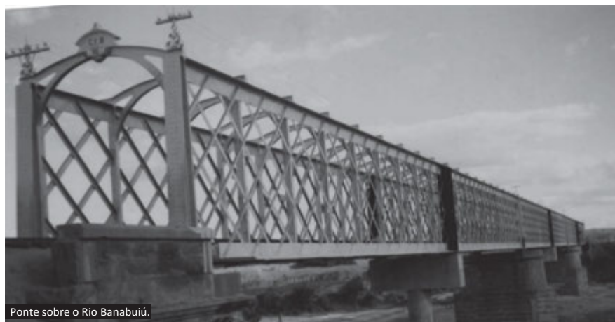
Ponte sobre o Rio Banabuiú.
