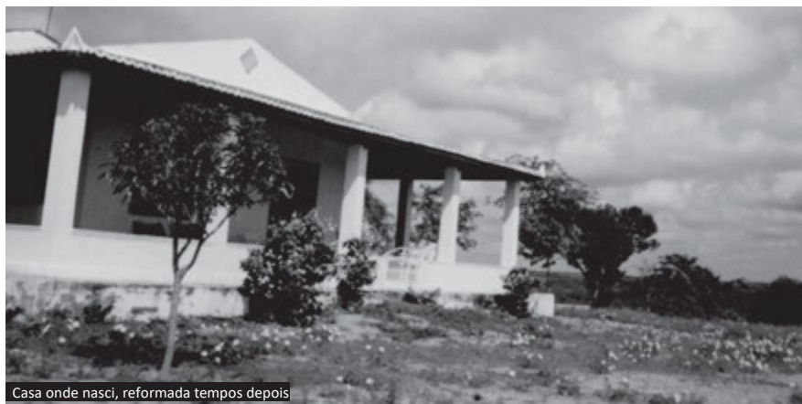
Casa onde nasci, reformada tempos depois
