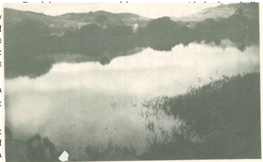
Açude construído pelo Ten. Cel. Almeida, no curso do riacho "São João" com o objetivo de irrigar as terras do "Sítio Monte". Ao fundo, à direita, junto à palmeira, estão o sangradouro e "tomada" d'água, para irrigação do sítio
