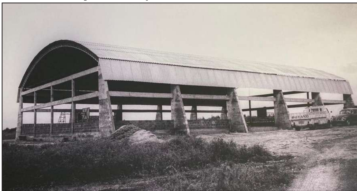
Figura 5 – Construção do “Ginásio A” da UNIFOR - 1977.
