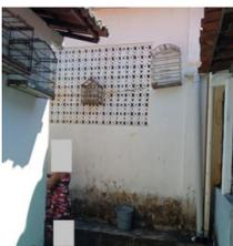
Área interna da vila, com paredes de alvenaria (na sua maioria sem reboco) com aproximadamente 2,5 a 3 m de altura.
