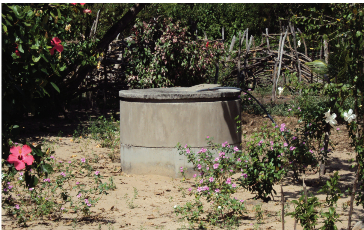
Poços escavados típicos da bacia
