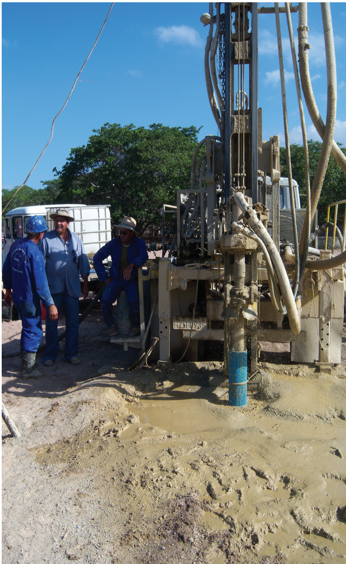
Itapipoca / Perfuração de poço
