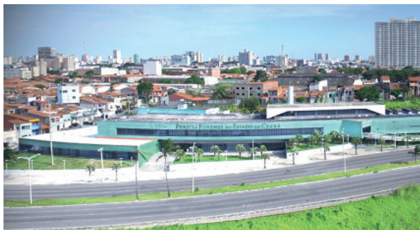
Figura 02 – Vista da sede da Perícia Forense do Estado do Ceará.
