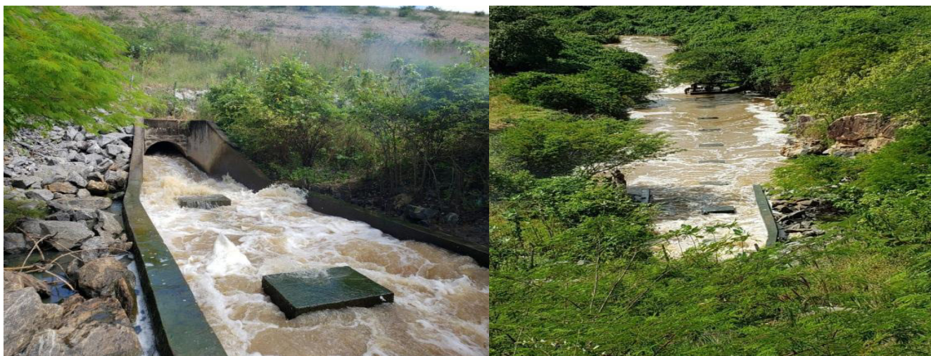
Figura 25 – Galerias do Açude Aracoiaba liberando água
