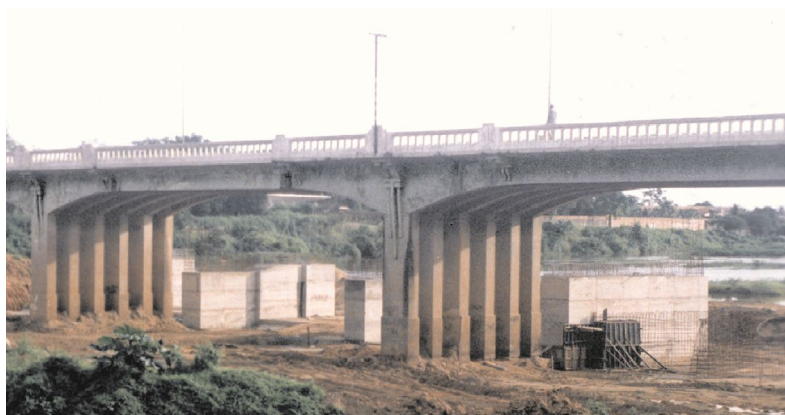
Figura 114: Ponte Otto de Alencar, vendo-se as fundações de sua duplicação. Fonte: Joselito Silveira: 2002.
