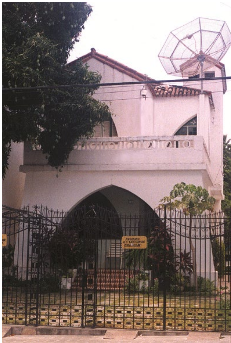
Figura 132: Residência Gonzaga Melo, Av. D. José, vizinha à residência Walter Araújo. Foto: Nelson de Paiva.
