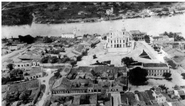
Figura 148: Foto aérea do centro de Sobral na década de 1960. Fonte: Arquivo José Alberto Dias Lopes.
