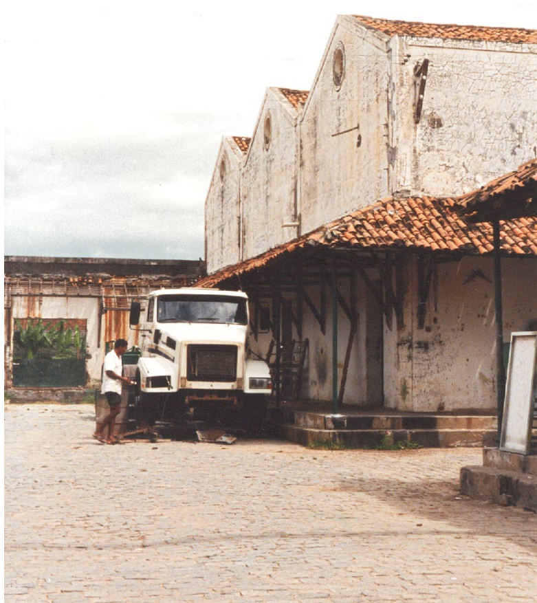
Figura 111: Pátio interno da Usina dos Araújo. Foto do Autor.
