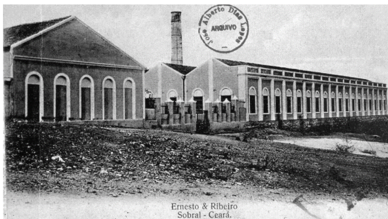
Figura 62: fachada principal da Fábrica de Tecidos Ernesto & Ribeiro. Fonte: Arquivo José Alberto Dias Lopes.
