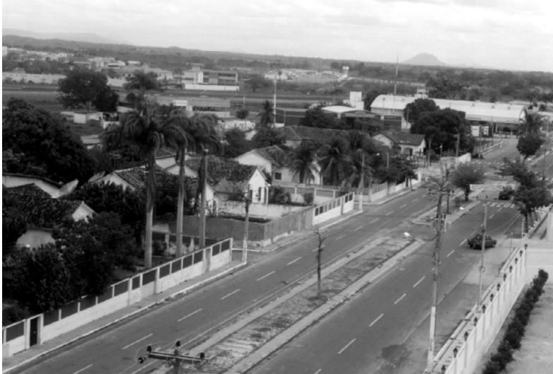
Figura 119: Vila Industrial da CIDAO. Foto do autor (2003).
