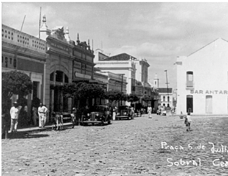
Figura 35: Fotografia a partir da Igreja do Rosário, provavelmente da década de 1940. Em destaque o Sobrado Cel. Francisco Joaquim de Souza Campello (demolido). Fonte: Arquivo José Alberto Dias Lopes.
