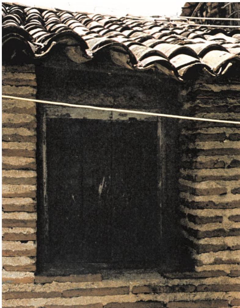
Figura 60: detalhe de parede de uma casa na antiga Rua do Rio. Foto: Aida Montenegro.
