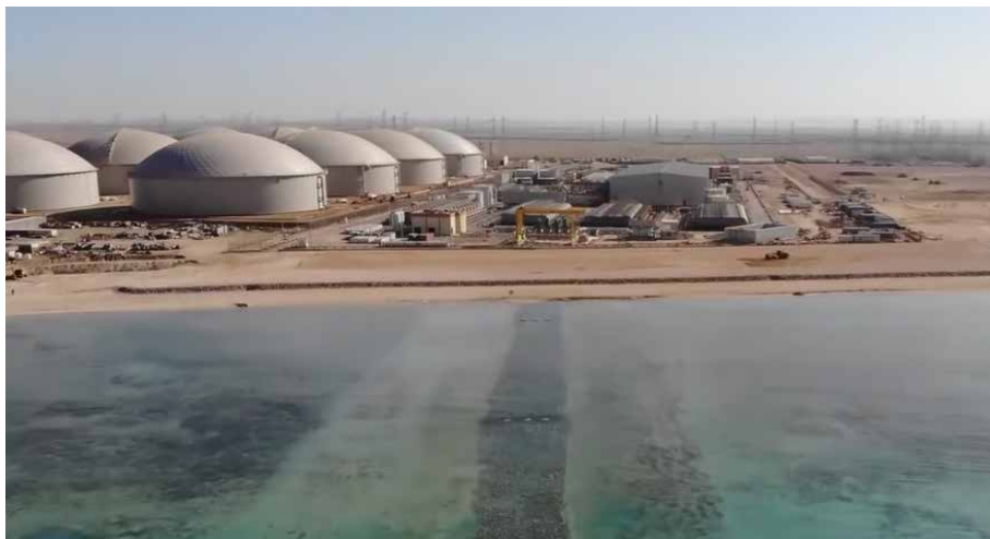
Figura 5 - Usina Rabigh 3, na Arábia Saudita, a maior usina de dessalinização de água marinha do mundo, com capacidade de produzir 600 mil m 3 de água por dia e abastecer aproximadamente três milhões de pessoas.
