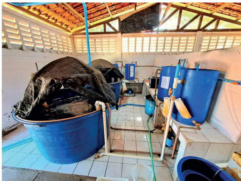
Figura 3. Sistema de recirculação de água montado para a execução do projeto. Foto: Viviana Lisboa.
