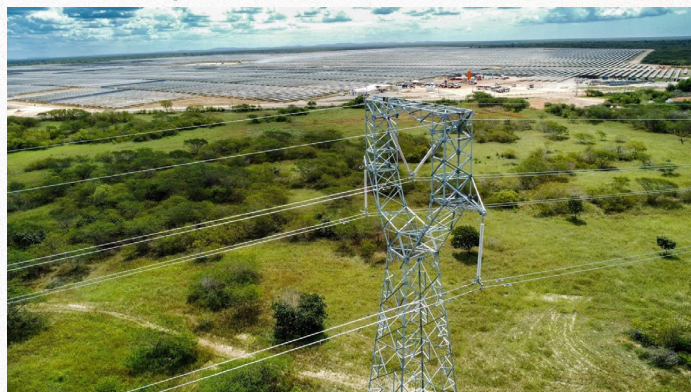
Figura 13 - Torre de transmissão.
