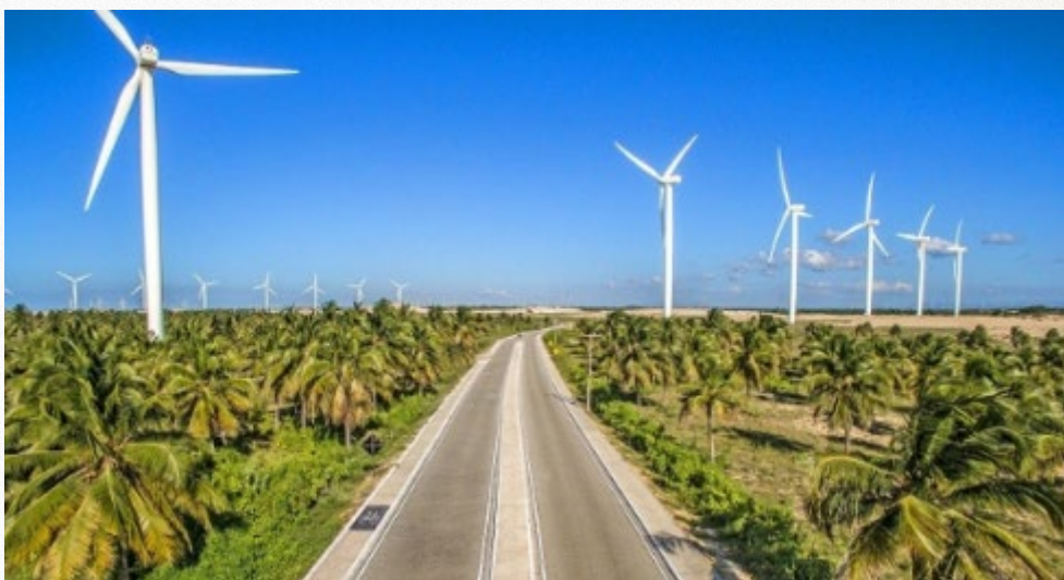
Figura 11 - Complexo eólico onshore .
