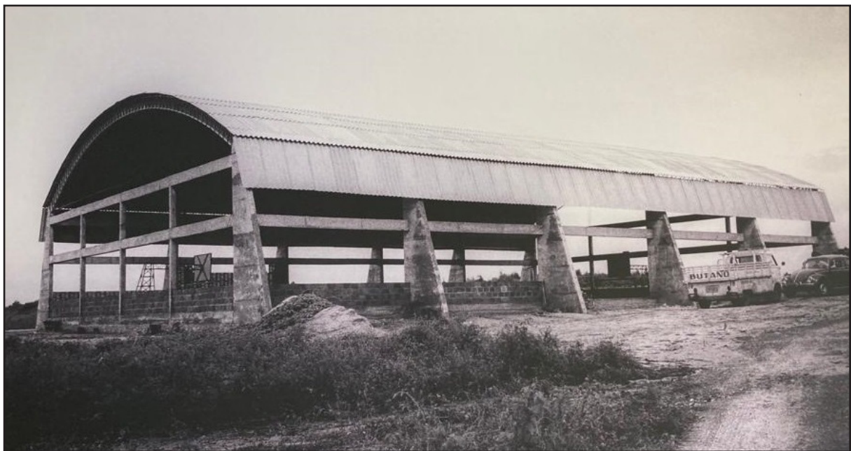
Figura 5 – Construção do "Ginásio A" da UNIFOR - 1977.
